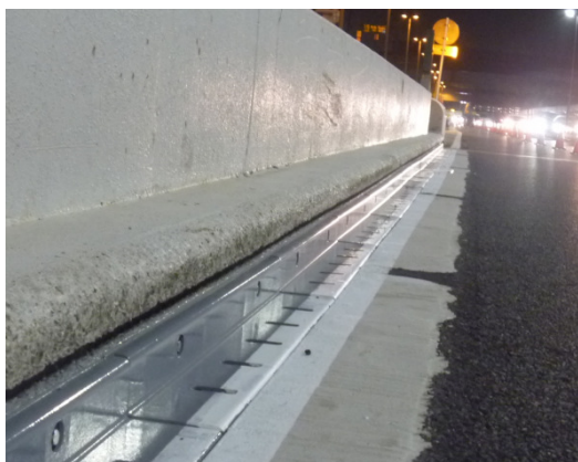
写真2 鋼製排水溝設置状況
