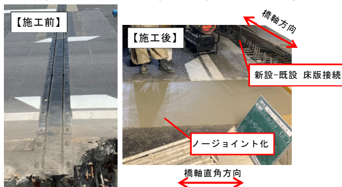
写真1 新設・既設のノージョイント化
