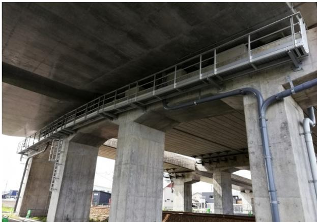
写真1 戸破高架橋 P9 橋脚 アルミ合金製下部工検査路
