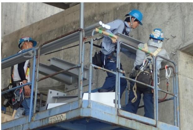
写真3 アルミ鋳物ブラケットの取り付け
