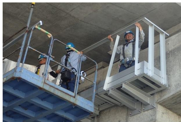
写真6 支柱、手摺りの取り付け
