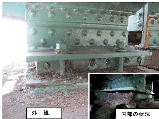
写真 2 取替え支承の損傷状況
