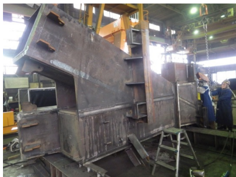
写真1 特殊構造物の例（上段分岐柱）
