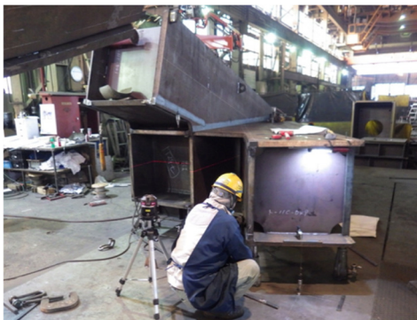
写真4 下げ振り、定盤ケガキを用いた製作手法
