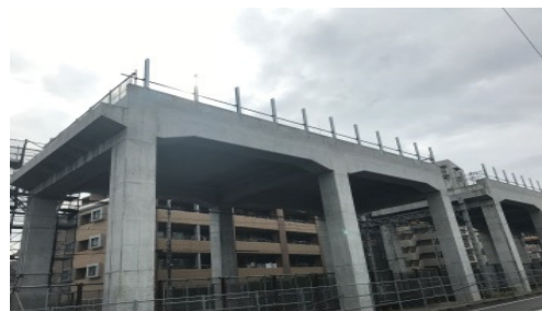
写真 6 ハーフプレキャストラーメン高架橋全景
