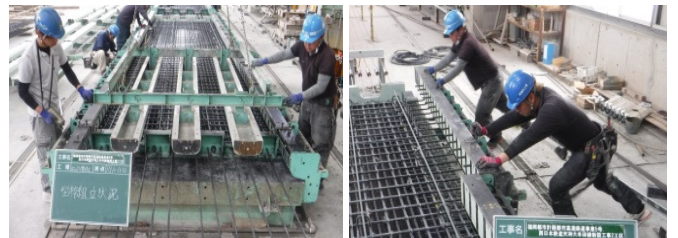
写真 5 型枠組立状況
