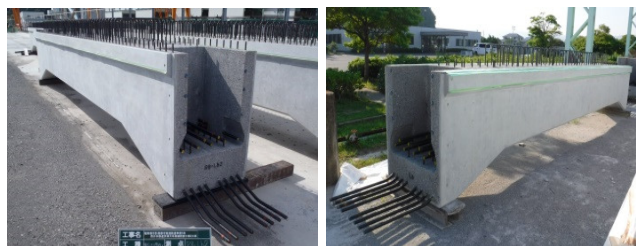
a) 縦梁 b) 中間横梁 写真 1-1 ハーフプレキャスト部材
