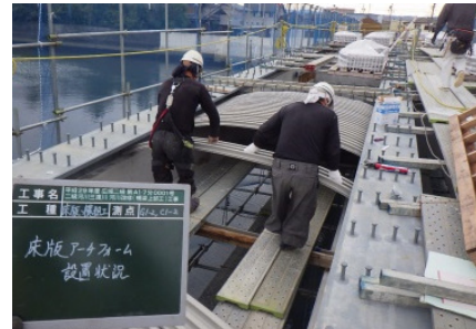
写真3 アーチフォーム設置状況
