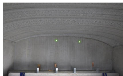
写真5 アーチフォーム設置完了(下面)
