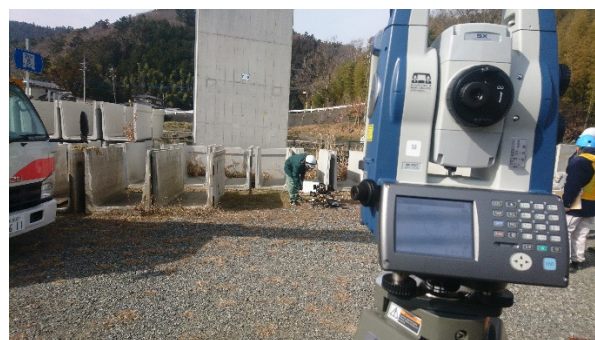
図2 トータルステーションによる計測
