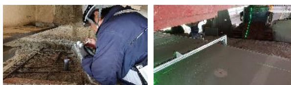
図2 削孔位置の転写作業
