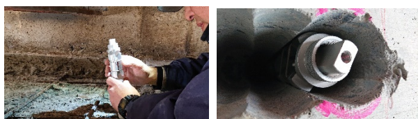
図 6 削孔部に挿入
