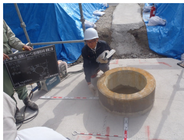
写真4 監理者による杭芯確認
