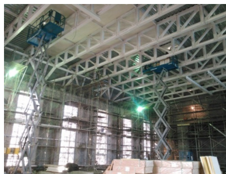
内部仕上げ工事
