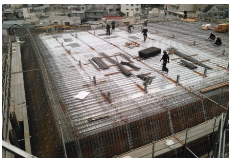
斜壁・スラブ躯体工事
