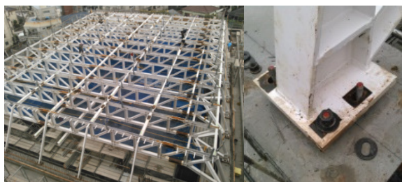
トラス架設後
