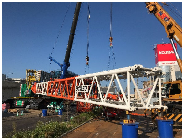
写真1 1250t吊クローラクレーン組立状況
