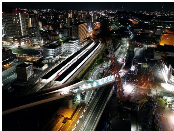
写真5 大ブロック一括架設状況
