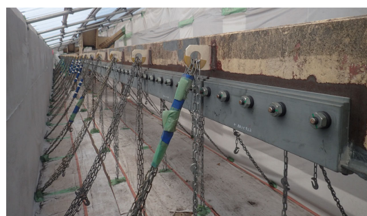
写真 3 下弦材の当て板補強設置状況
