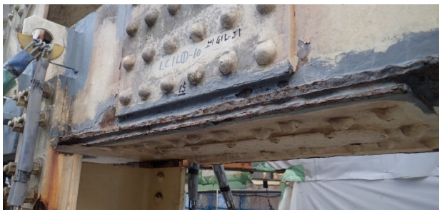
写真-10 下弦材の添接部
