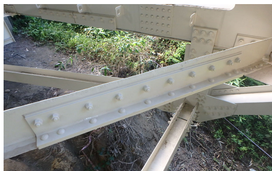
写真 7 下横構の当て板補強設置状況
