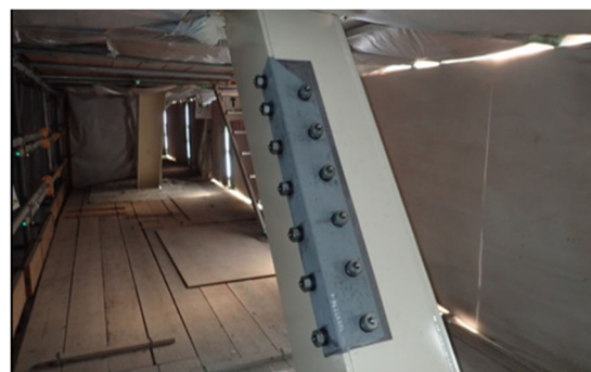
写真 4 斜材の当て板補強設置状況
