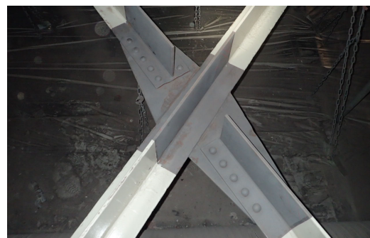
写真 6 下横構中間ガセットの取替
