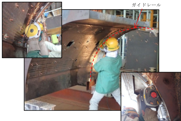
写真 3 カバーPL 曲線部の切断状況
