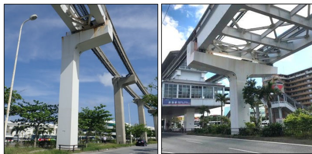
写真1 橋脚外観例（左：逆L型，右：T
