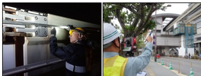
夜間軌道桁計測
