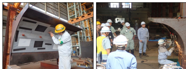
写真2 カバーPL撤去方法の施工試験風景
