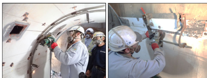
Step2:チップソー曲線部切削
