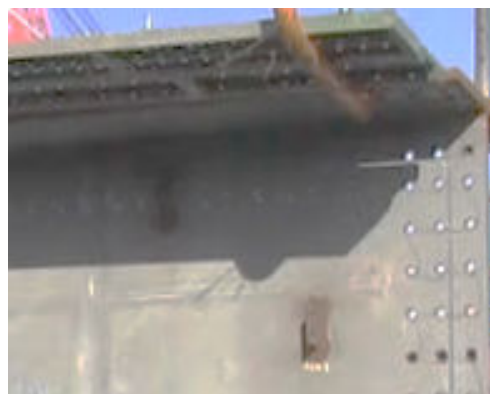
(a) 実物の鋼桁
