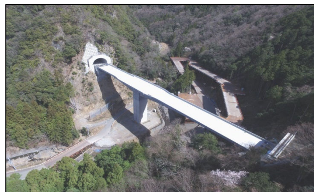
写真 13 橋梁完成 (ドローン撮影)
