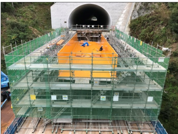
写真5 A1 先行施工部施工
