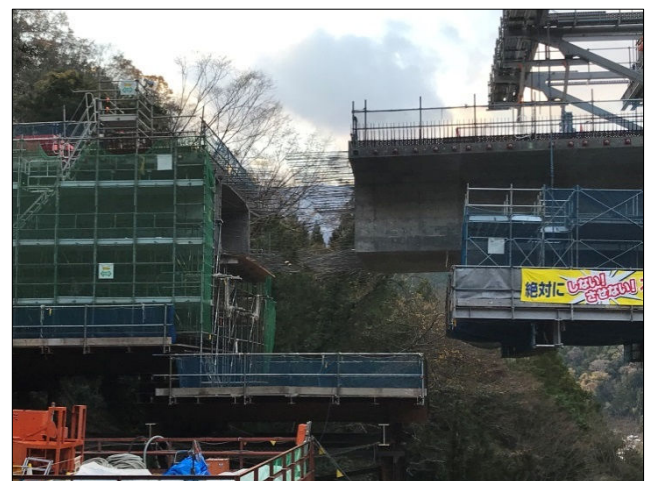
写真9 移動作業車の後退
