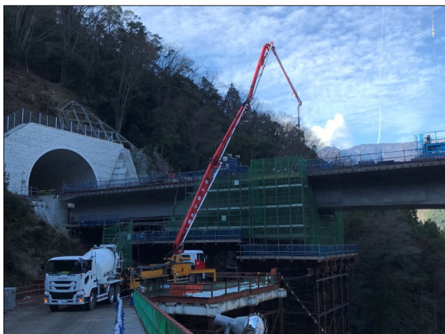
写真 10 閉合部コンリート打設
