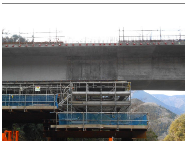
写真 11 閉合部脱型後
