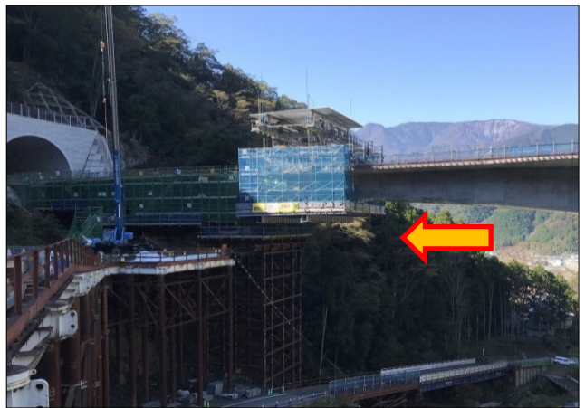
写真8 リフトアップ後
