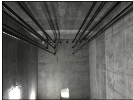
写真2 箱桁内部
