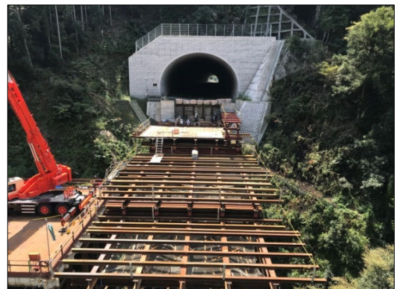
写真3 A1梁支柱式支保工
