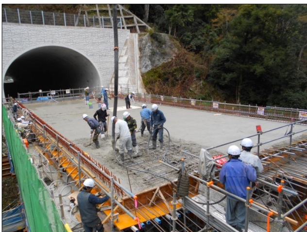
写真6 A1 先行施工部コンクリート打設状況
