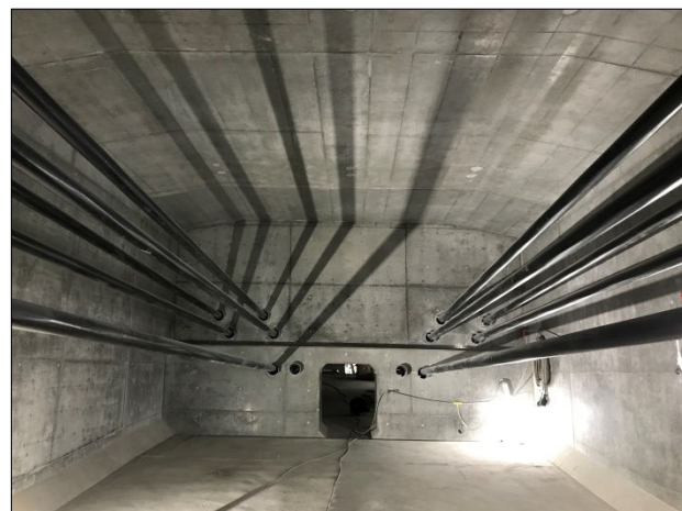
写真 12 箱桁内外ケーブル偏向部
