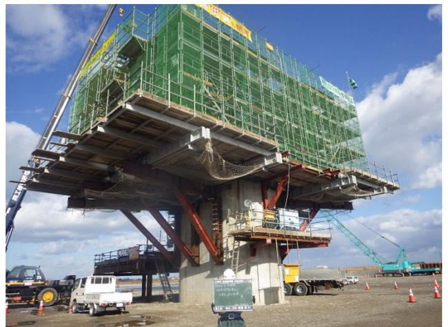
写真3 移動作業車作業床の先行設置
