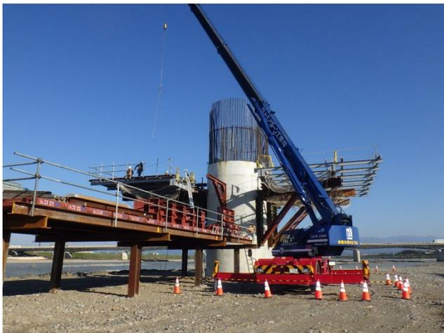
写真2 ブラケット支保工および架設構台
