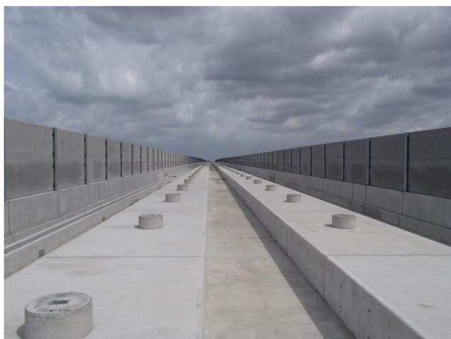
写真 11 路盤施工完了
