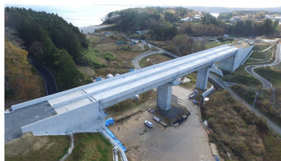
写真 8 登米沢橋の全景（2019 年撮影）
