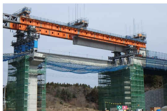
写真 6 主桁の架設状況 (登米沢橋)
