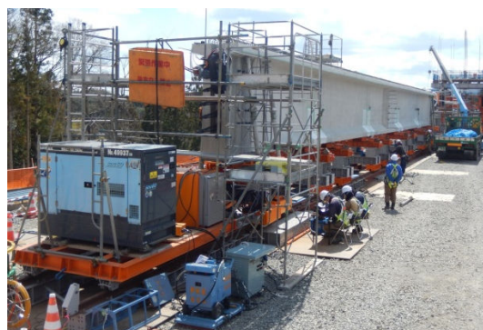
写真 5 PC 鋼材の緊張作業状況 (登米沢橋)
