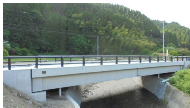
写真 2 行屋橋全景（2016 年撮影）
