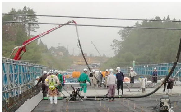
写真 7 場所打ちコンクリートの打設状況（登米沢橋）
