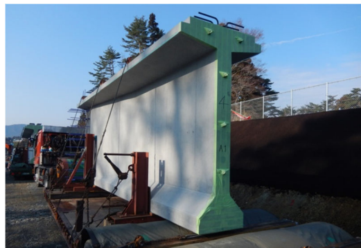
写真 4 主桁部材の搬入 (登米沢橋)
