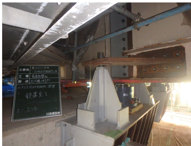
写真 4 仮固定構造（縦型ピン構造）
