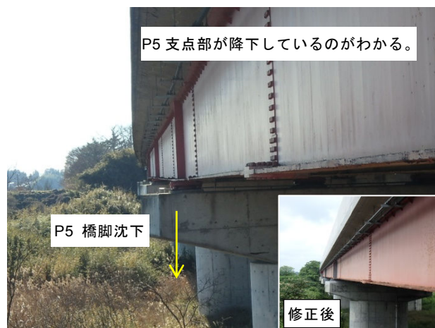
写真3 主桁線形異常状況
