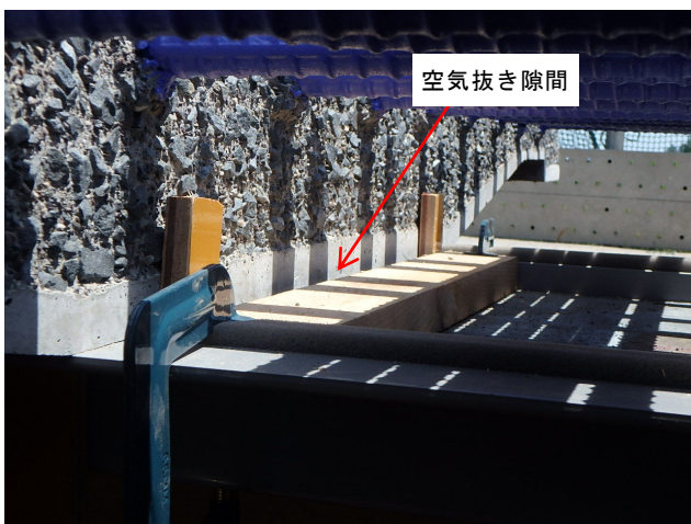
写真9 フランジ上型枠設置状況
