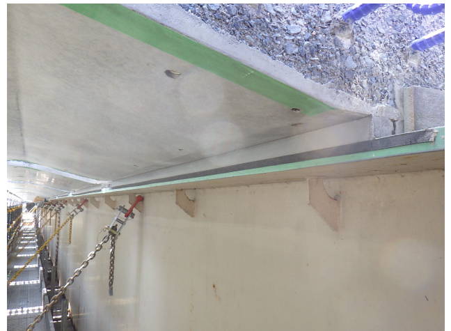
写真10 無収縮モルタル充填完了
