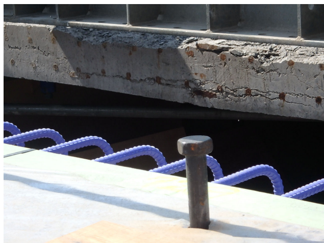
写真1 床版損傷状況
