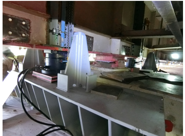
写真7 ジャッキアップ状況
