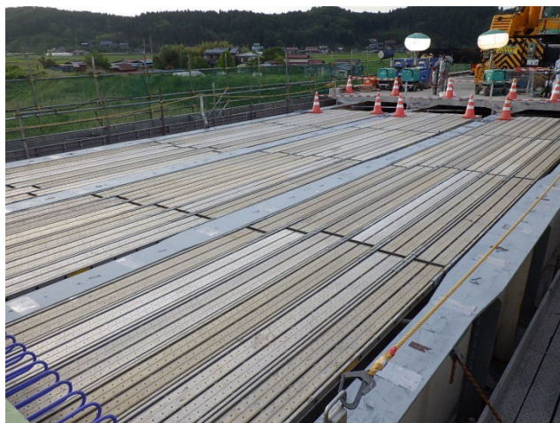
写真 11 全面足場設置状況
