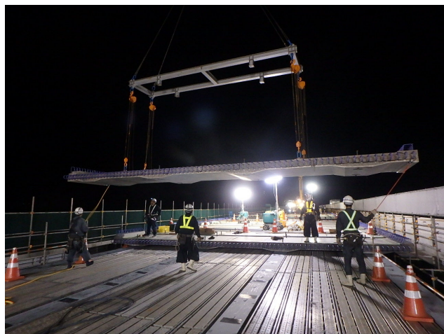
写真 12 夜間の作業状況
