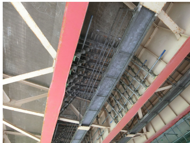
写真 13 下り線の応急対策
