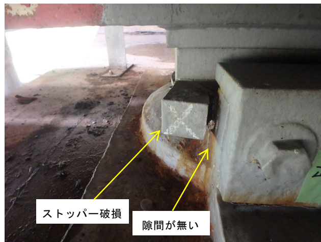
写真2 支承損傷状況
