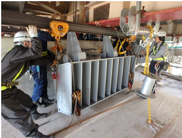
写真6 下部エブラケット取込み状況
