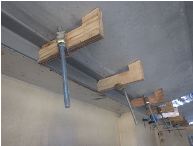
写真8 塩ビ型枠工法
