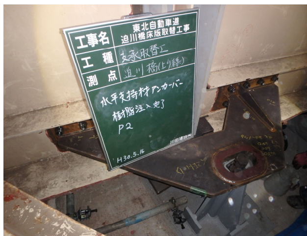
写真 5 上部仮固定具（可動部）
