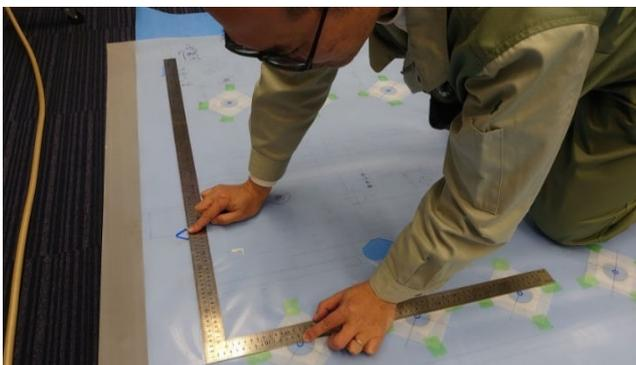
図1 削孔位置採寸作業
