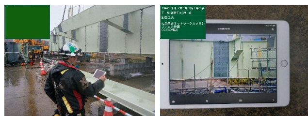
写真2,3 桁の地切り時の確認状況
