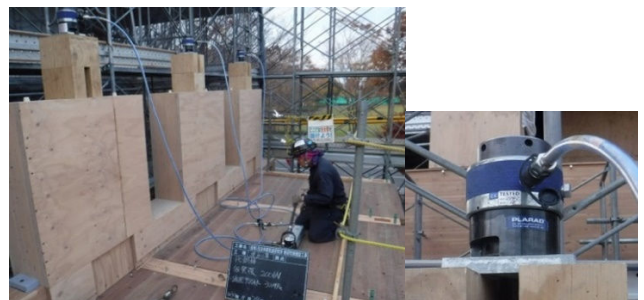
PC鋼棒仮緊張作業状況
