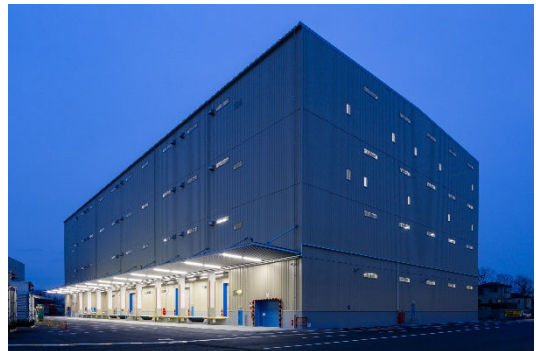
日本梱包運輸倉庫株式会社 狭山倉庫
