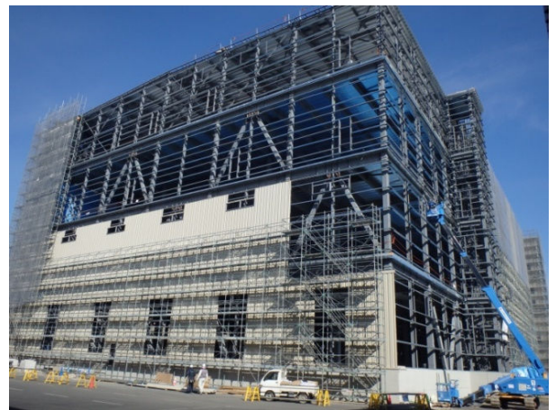
現場施工状況
