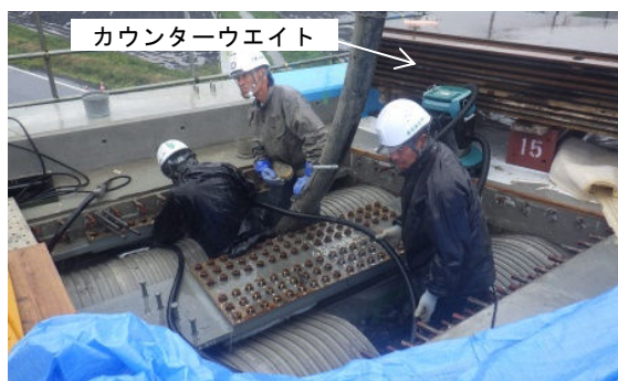
写真 1 下フランジコンクリート連結部の打設状況
