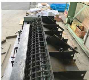
写真3 柱型枠
