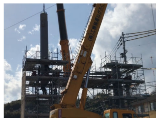
写真12 柱架設(参考)
