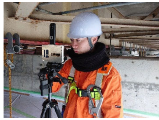
写真2 迫川橋取得状況
