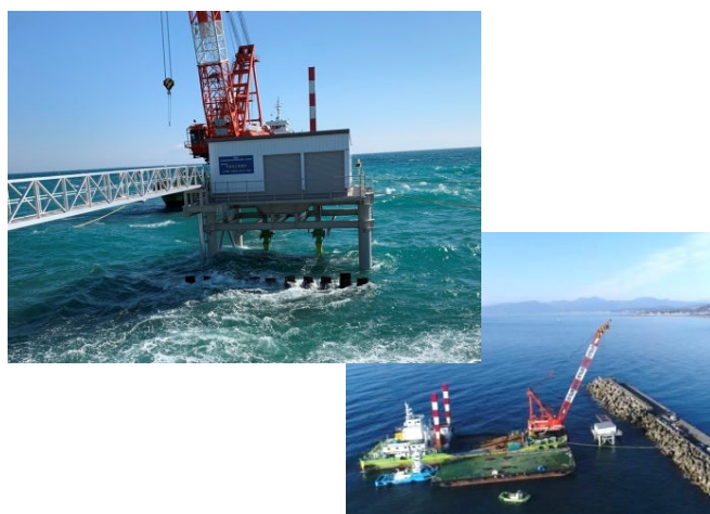
写真5 現地施工状況
