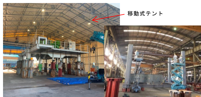
a) 上部デッキ施工
