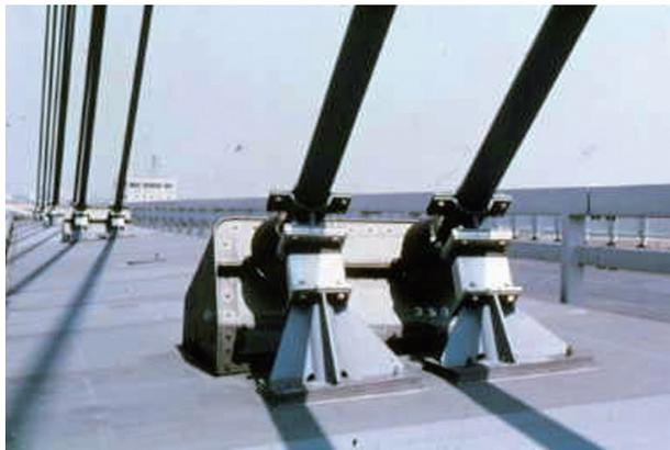
写真-2 ケーブル制振用粘性せん断型ダンパー（幸魂大橋）
