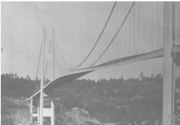
写真-4 旧タコマナローズ橋で発現したねじれフラッター
