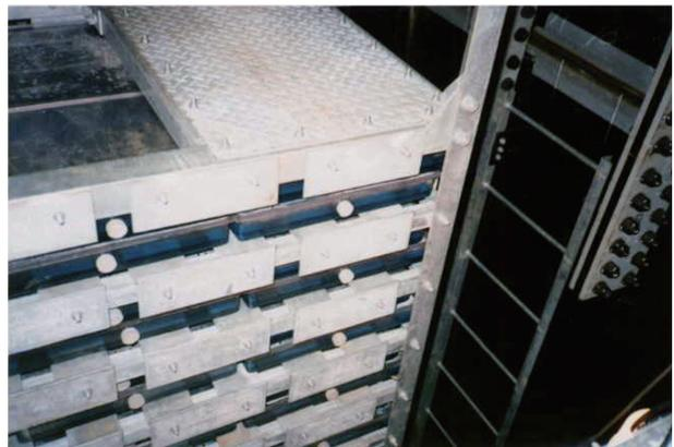
写真-3 幸魂大橋主塔で採用したTLD (Tuned Liquid Damper)
