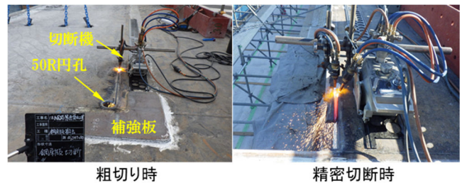
写真9 ポータブル自動ガス切断機での切断の様子
