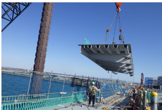
写真6 鋼床版張出部の架設状況
