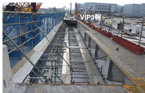
写真5 鋼床版張出部の撤去状況 (J47 から GE2 を望む)
