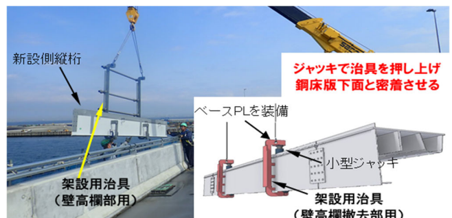
写真10 側縦桁架設時状況と使用概略図
