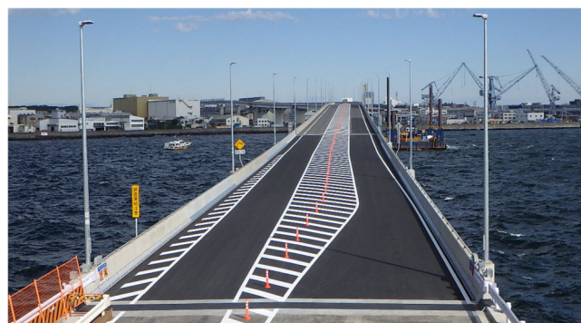
写真12 供用再開直前の様子
