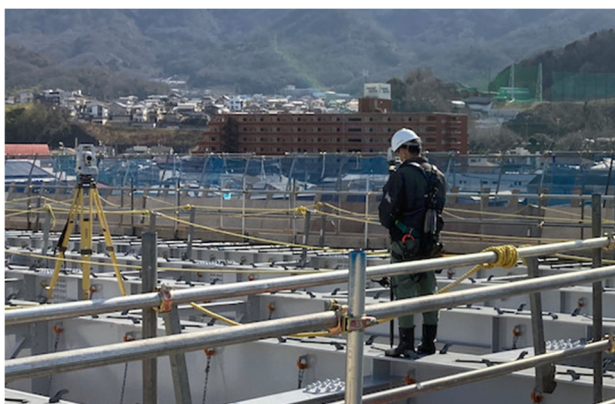
(a) 海田高架橋5号橋
