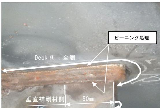
写真2 溶接部の仕端仕上げ状況
