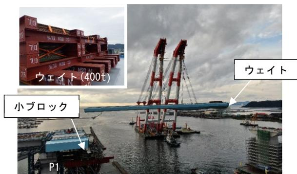
写真 6 ウェイトを搭載した大ブロック架設
