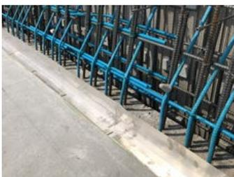
写真3 ステンレス板設置
