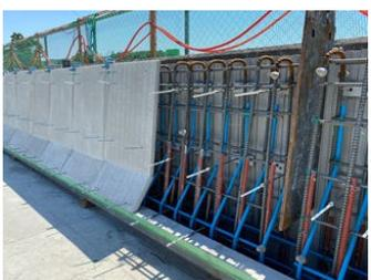
写真5 上側埋設型枠設置
