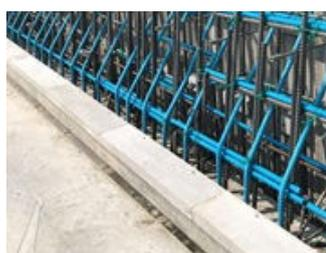
写真4 下側埋設型枠設置
