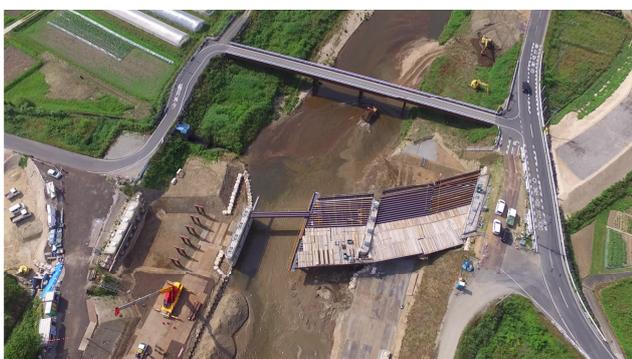
写真7 H鋼梁の架設状況
