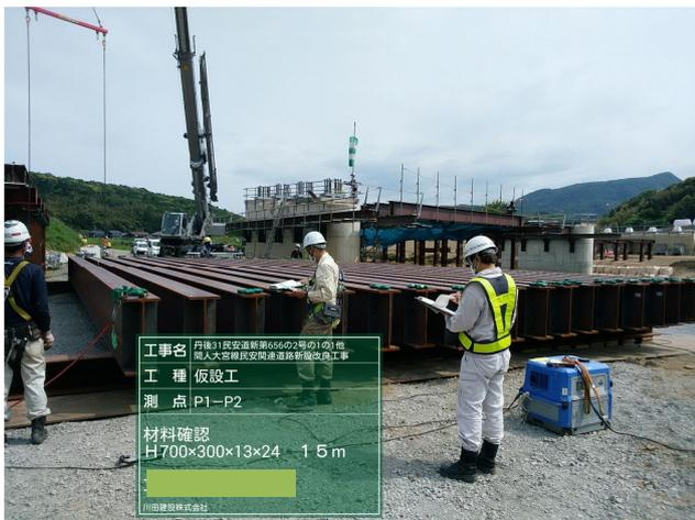
写真6 H型鋼梁の材料確認状況
