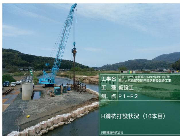
写真 4 H 鋼杭打設（瀬替え時）
