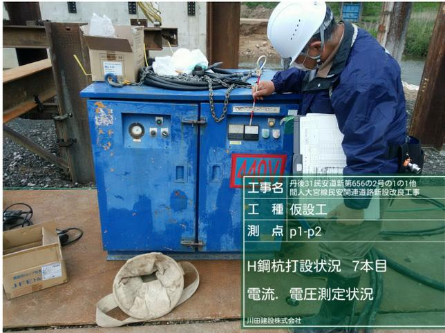
写真5 電流、電圧確認
