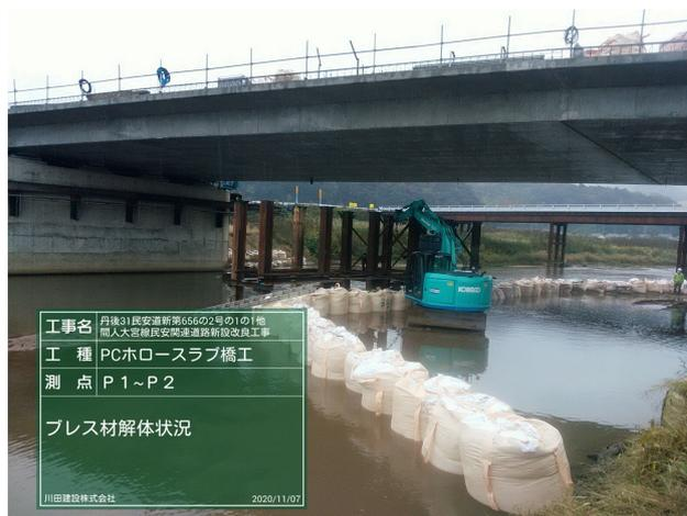
写真 3 大型土のう設置（支保工解体時）
