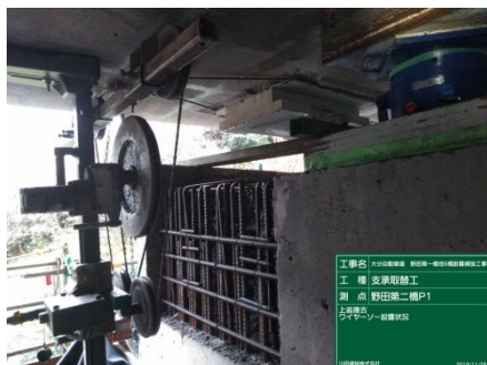
写真6 既設支承切断作業
