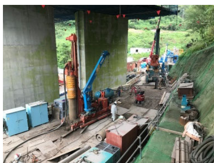
写真 12 P1 橋脚部小型杭打機による掘削作業
