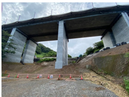
写真 16 コンクリート巻立て完了
