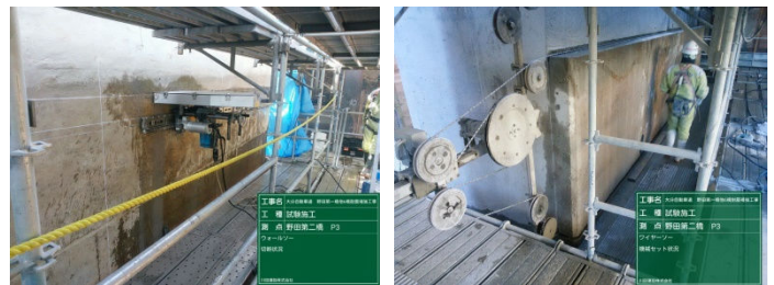
写真 13 ウォールソー切斷 写真 14 ワイヤーソー切斷
