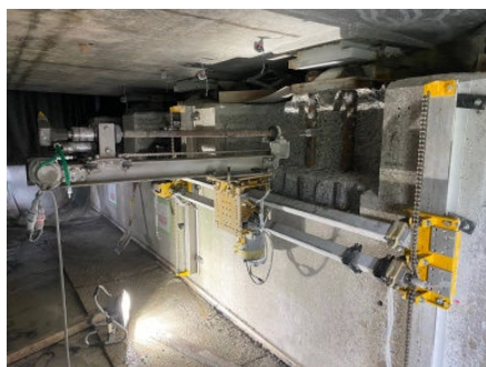
写真7 橋台コンクリート撤去作業
