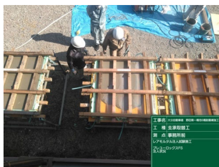
写真10 無収縮モルタル注入試験
