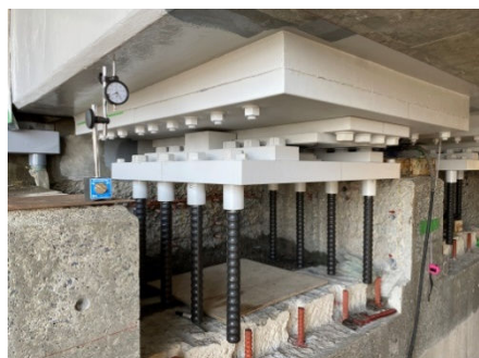
写真3 A2橋台新規ゴム支承
