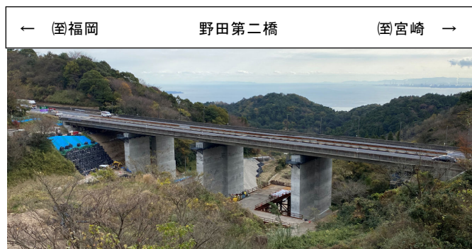
写真1 野田第二橋全景
