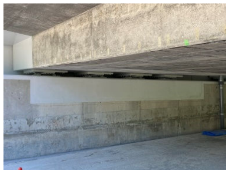
写真11 復旧コンクリート・表面保護工完了
