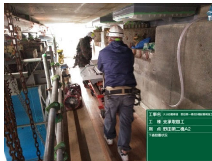
写真4 重量台車で移動作業
