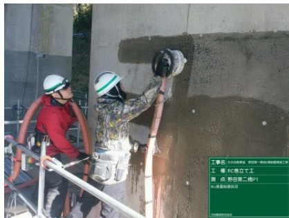
写真 15 表面処理作業 WJ 工法
