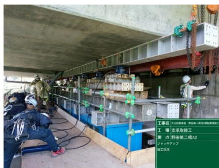
写真5 A2橋台ジャッキアップ作業
