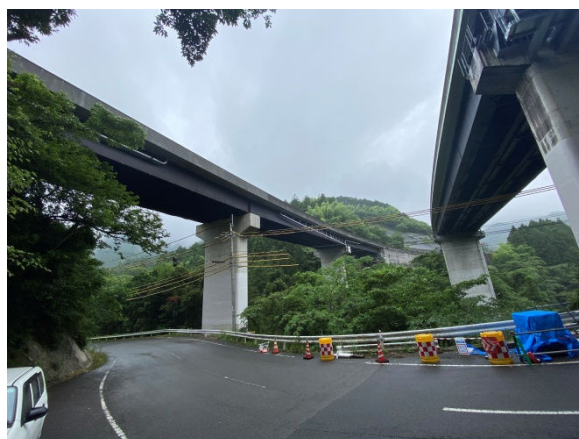
写真4 松久保橋（左側が下り線）
