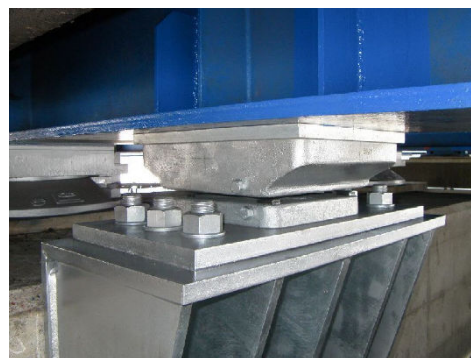
写真 1 水平力分担構造工（せん断ストッパー）
