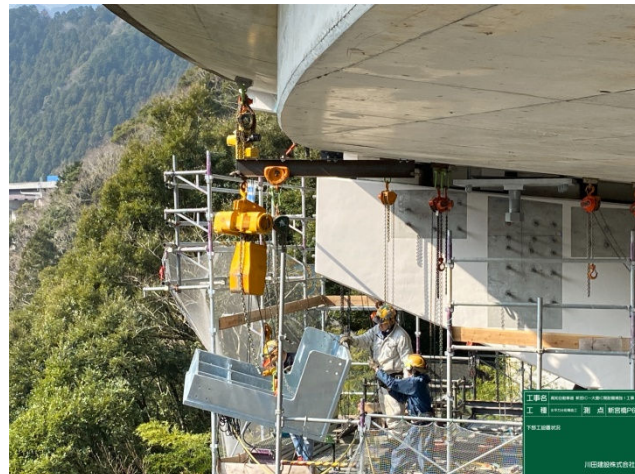
写真9 電動チェーンブロックによる部材荷上げ状況
