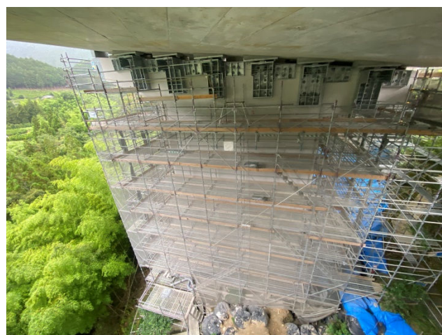
写真12 部材取付け完了
