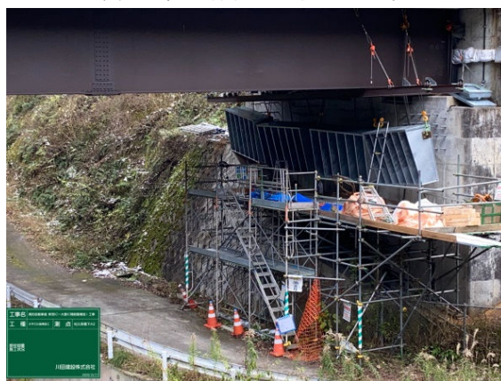
写真5 下部工ブラケット設置状況
