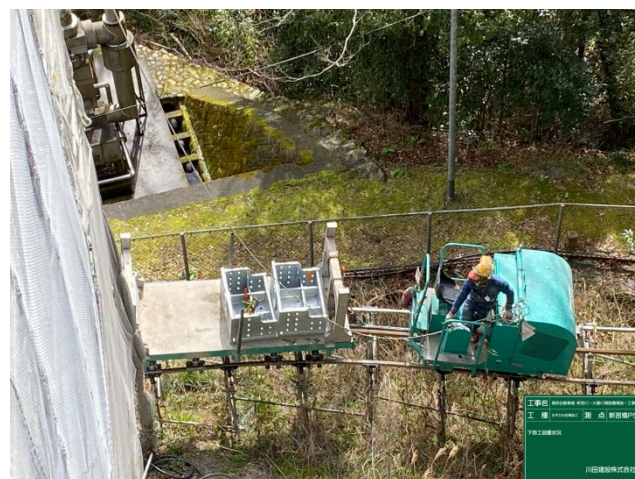
写真8 モノレールによる部材運搬状況
