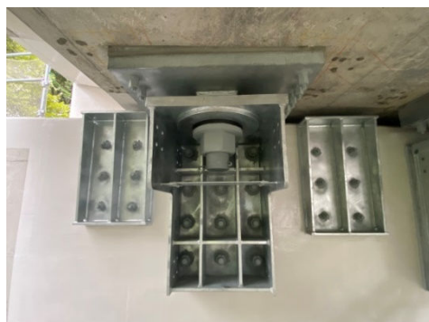
写真 2 水平力分担構造工 (PRF 緩衝ピン BT) (中央)
