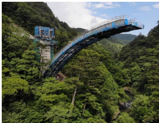
写真10 鋼メラン材片側架設完了状況
