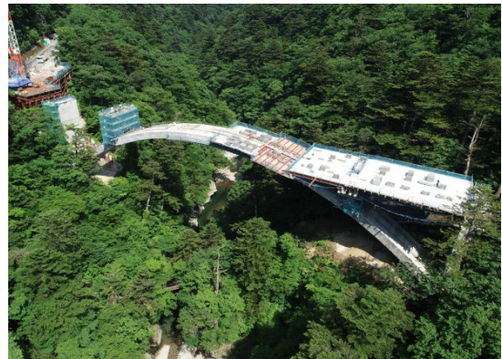
写真 13 仮設構台解体・補剛桁支保工組立状況
