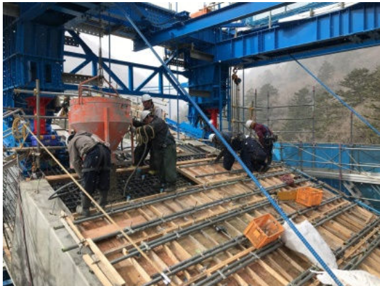
写真 12 2次コンクリート打設状況
