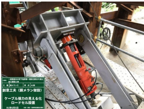
写真9 ロードセルによる張力確認
