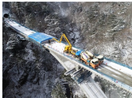
写真 14 補剛桁上からのクラウン部の施工
