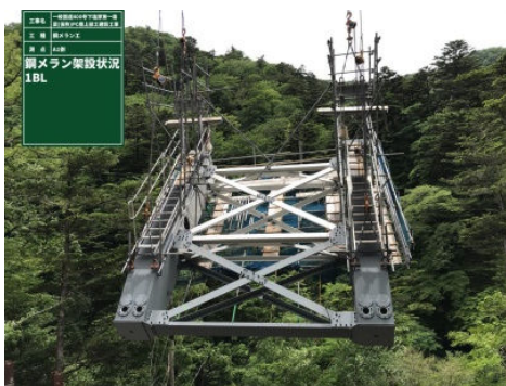
写真8 鋼メラン材架設状況
