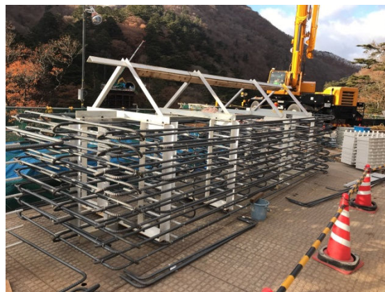
写真4 中間帯鉄筋先行組立て状況
