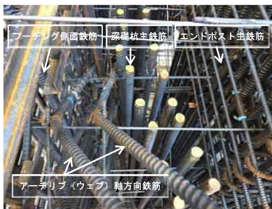
写真3 ウェブ軸方向鉄筋の埋込み定着部
