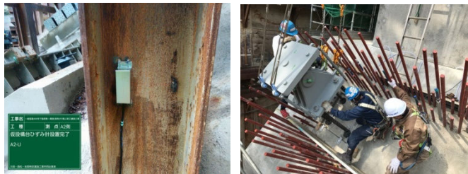
写真6 ひずみ計設置状況 写真7 ピン支承接付け状況
