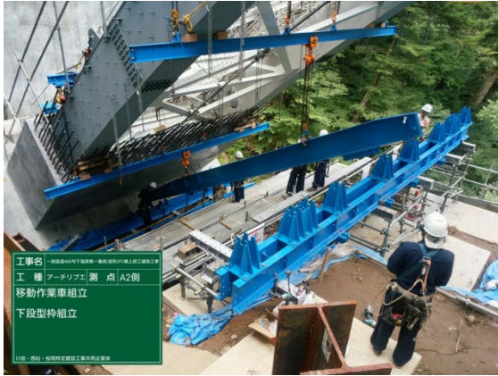
写真11 作業台上での巻立て作業車の組立状況
