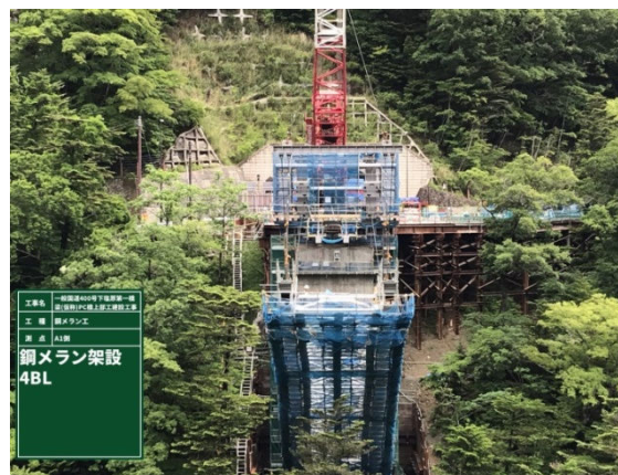
写真5 鋼メラン斜吊り張出架設状況
