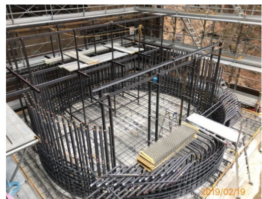
写真2 鉄筋組立て用架台
