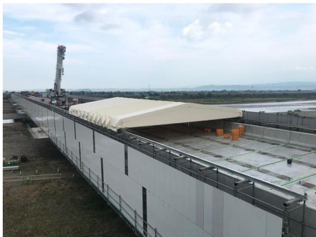
写真7 作業上屋の設置状況
