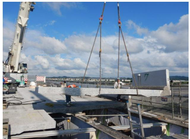
写真4 既設床版の撤去状況
