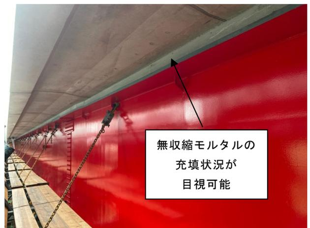
写真5 無収縮モルタルの充填状況
