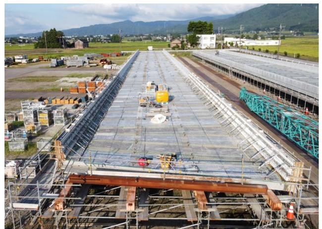
写真 2 壁高欄の製作場
