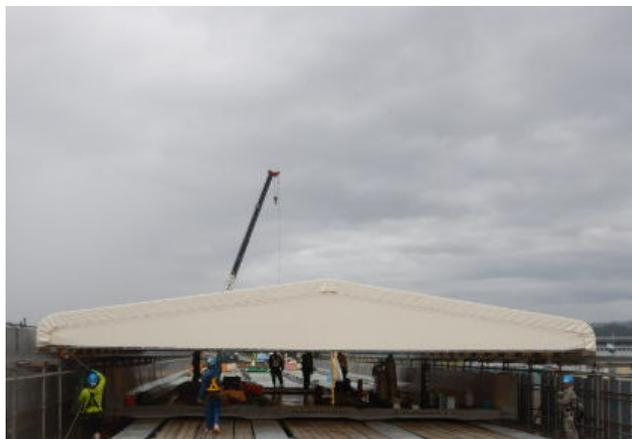
写真8 作業上屋の移動状況
