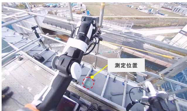
写真 8 アバターロボット視点の標高測量映像
