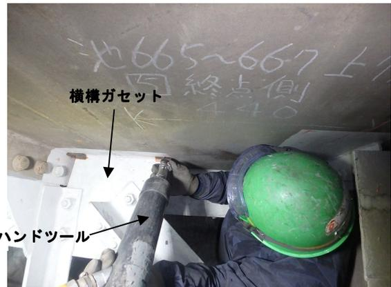
写真 3 UIT 施工状況
