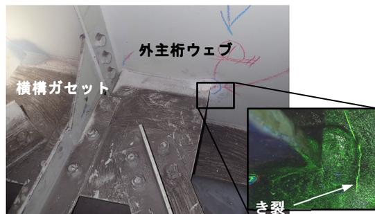
写真1 横構ガセット部のき裂
