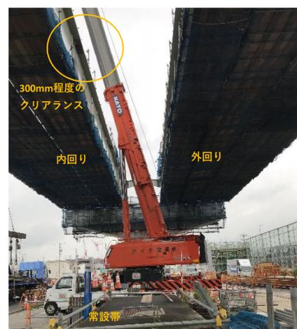
写真3 プレキャストPC床版架設状況
