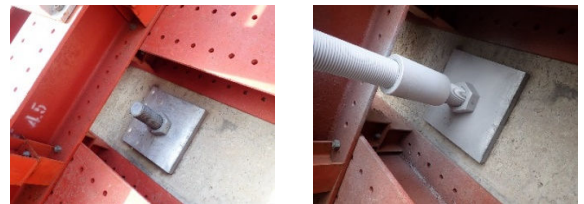
写真1 タイブルアンカーの連結
