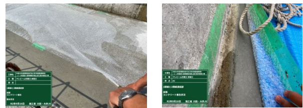
エアキャップシート養生 養生中の湿潤状態 写真2 湿潤養生状況
