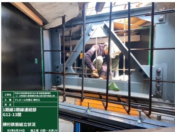
写真1 連結部の施工状況
