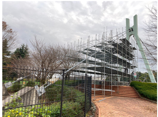
写真 2 ケーブル周りの足場組立状況
