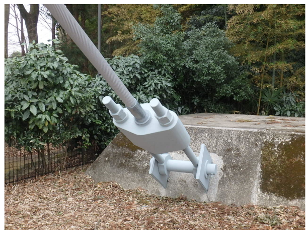
写真 3 ケーブル補修状況
