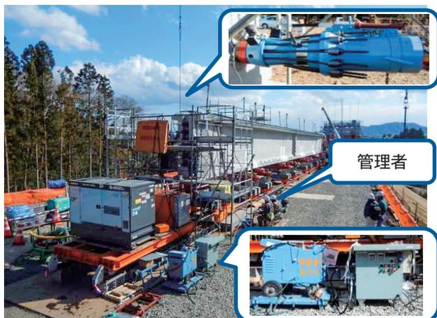
写真9 自動化した緊張作業全景
