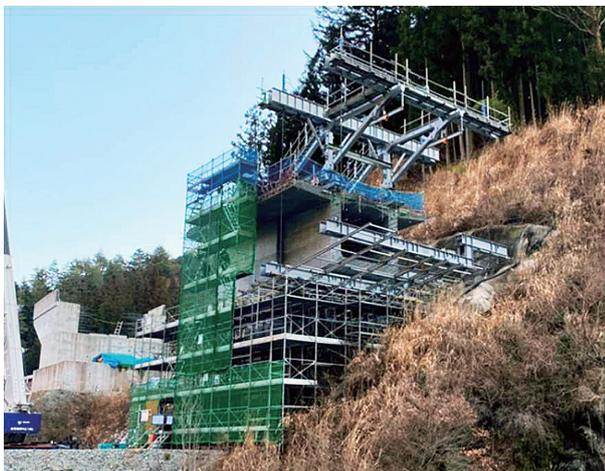
写真 8 超低床移動作業車の全景
