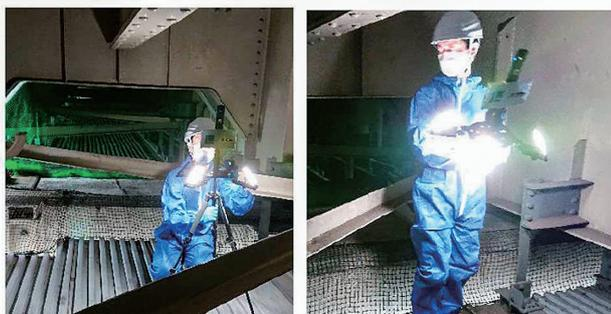
写真14 桁内部で3D情報を取得する様子
