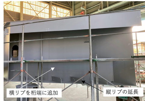
写真 2 G1 桁の A2 側桁端部
