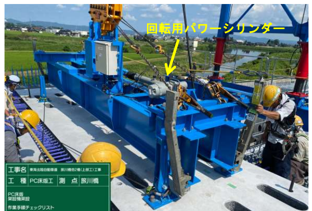
c) 架設状況
