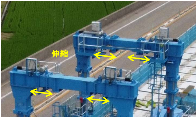
写真2 門型の伸縮によるレール幅の変更
