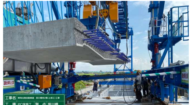
a) 吊上げ状況
