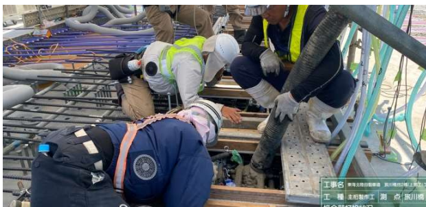
a) 高流動コンクリート打設状況
