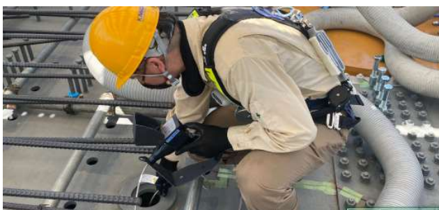
b) CCD カメラによる充填確認状況 写真 7 打設状況 (旅川橋)
