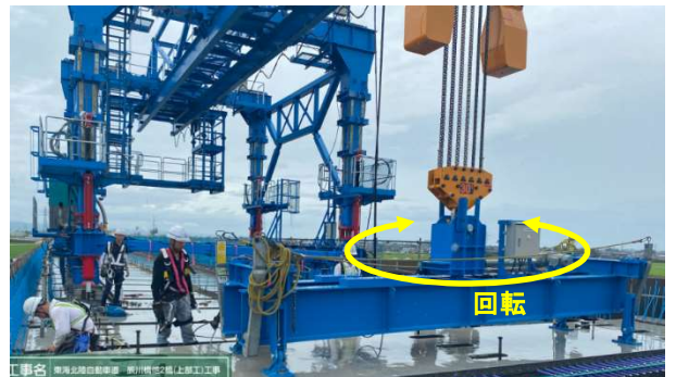
b) 架設状況
