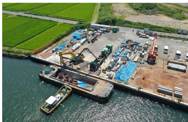
写真 8 コンクリート積込状況（函体ヤード）
