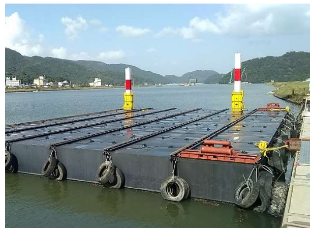
写真18 資材台船組立完了
