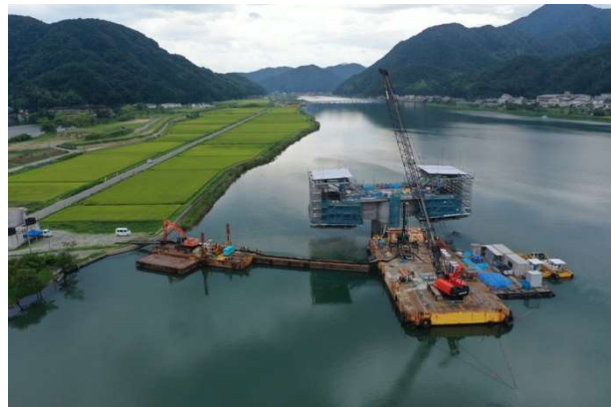
写真14 コンクリート打設状況（出水期）
