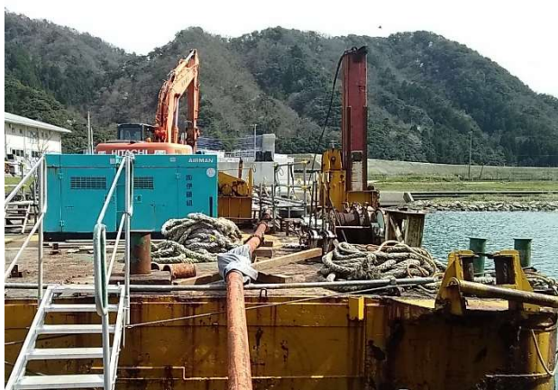
写真12 配管状況（段差部）
