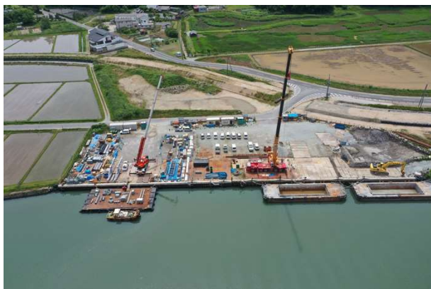
写真2 函体ヤード（岸壁）
