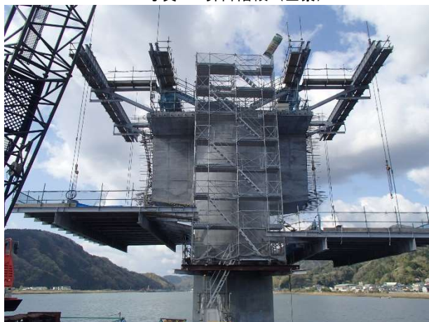
写真5 昇降階段（全景）
