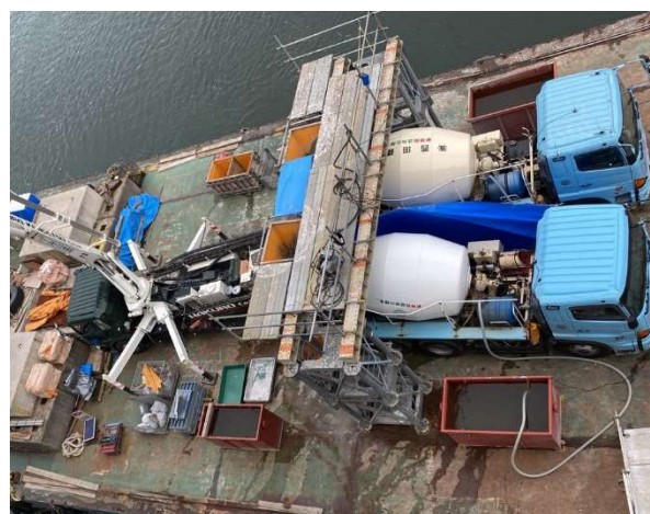
写真 11 ポンプ車配置（台船上）
