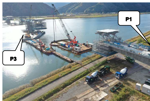
写真7 コンクリート打設状況（中州エリアより）
