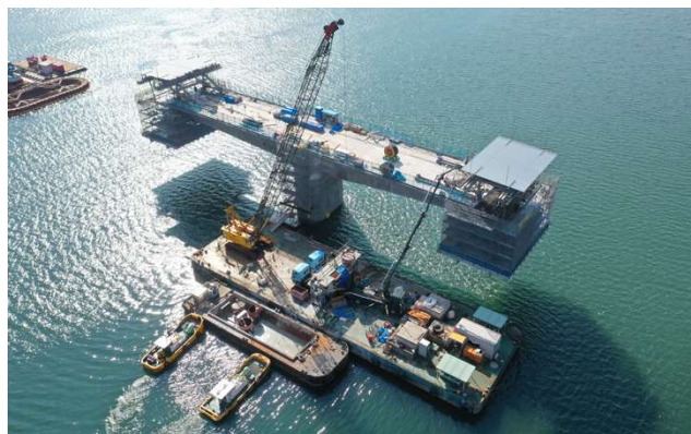
写真 9 P3 コンクリート打設状況
