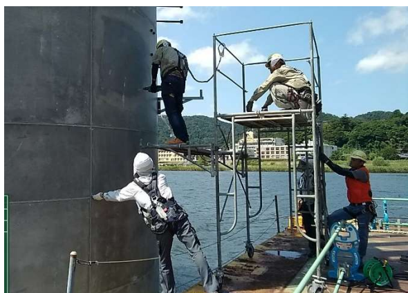
写真3 仮設足場設置状況
