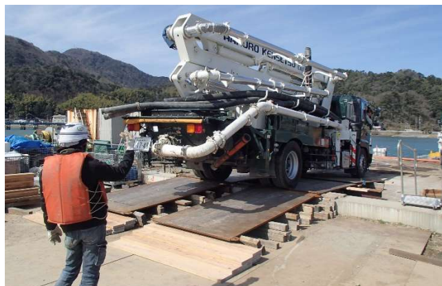
写真6 ポンプ車搭載状況（函体ヤードにて）
