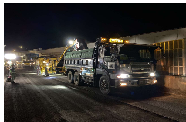
写真4 アスファルト舗装切削状況
