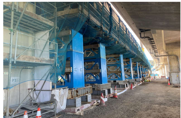
写真3 支保工組立完了
