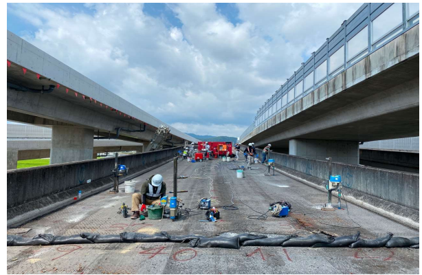
写真 5 コア削孔状況
