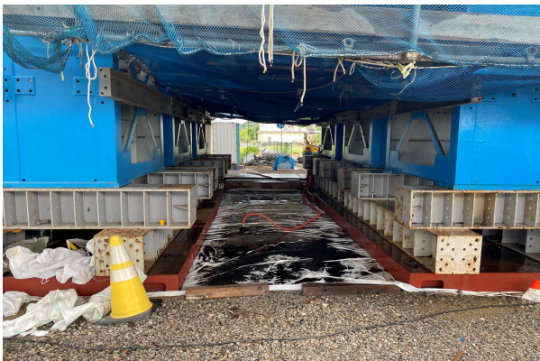
写真 11 残水処理状況
