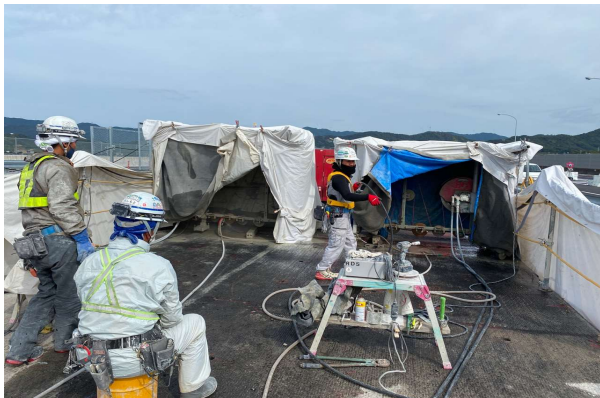
写真 6 ワイヤーソー切断状況
