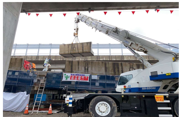
写真 8 25t クレーンによる張出床版撤去
