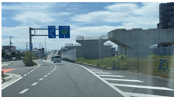
写真 2 施工位置写真（案内標識）
