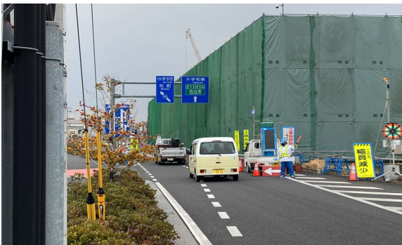
写真 3 工事看板視認性確保
