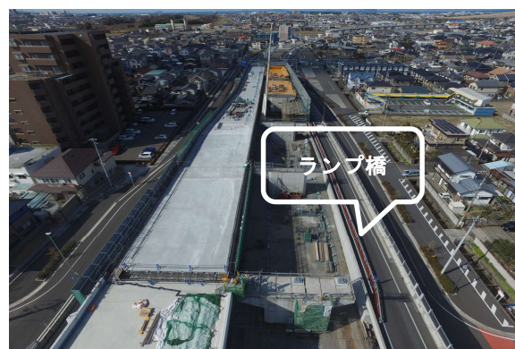
写真1 施工位置写真(ランプ橋)
