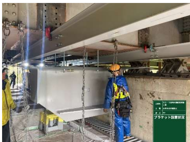
写真7 水平力分担構造（橋軸方向） ブラケット部材仮吊り状況
