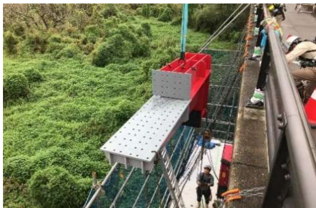
写真2 部材揚重「吊り孔」使用状況
