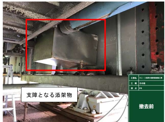
写真 11 部材取付け位置の添架物
