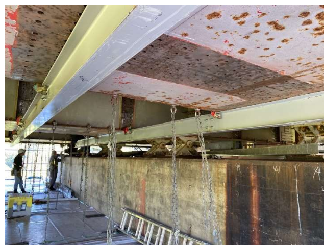
写真5 横移動設備設置
