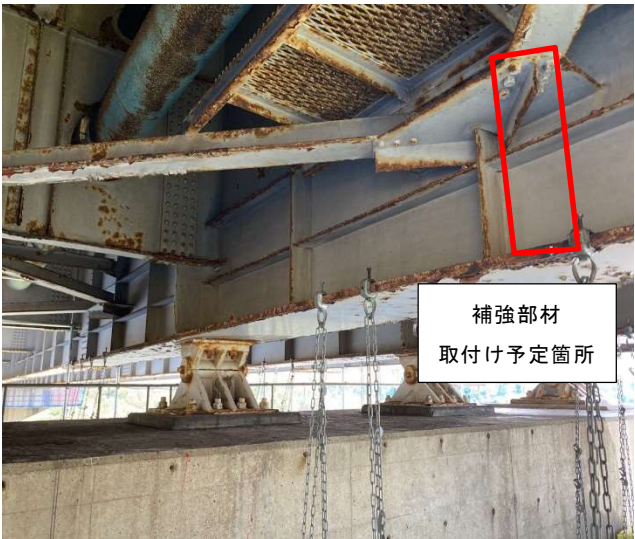
写真 16 P8I 桁部 (既設横構と補強部材の設置箇所)
