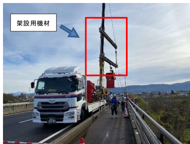
写真9 架設用機材使用状況
