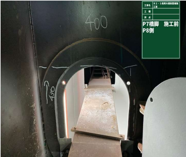
写真 14 箱桁内部（橋軸方向）の添架物
