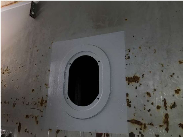
写真 15 部材取込み用マンホール設置状況
