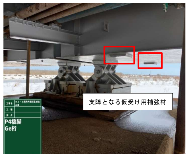
写真 12 仮受け用補強材
