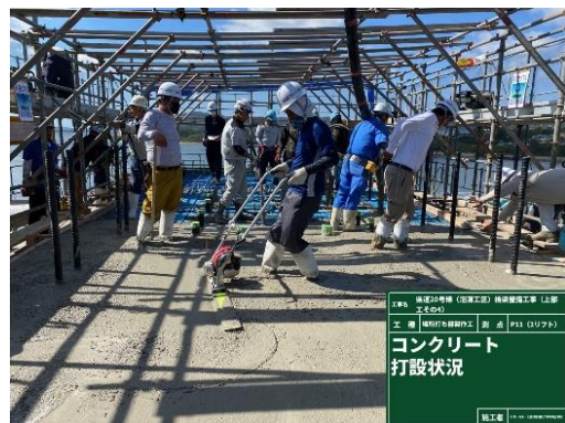
写真 14 マジックタンパーによる天端仕上げ
