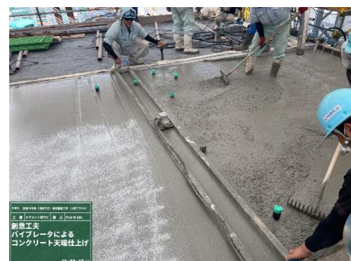
写真 4 セグメント桁天端仕上げ状況
