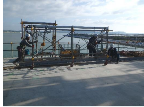
写真 10 レール移設状況
