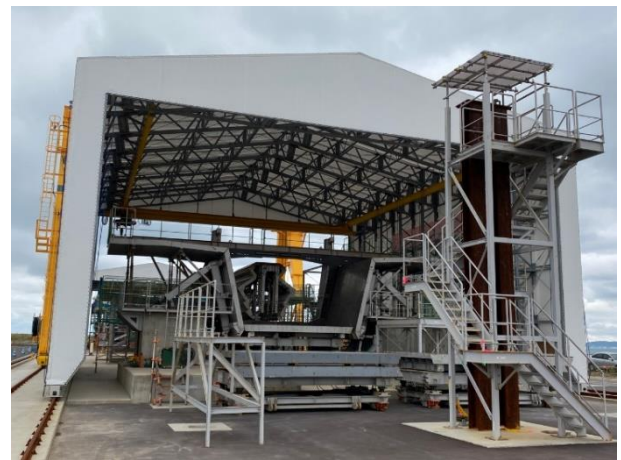
写真 2 セグメント製作台
