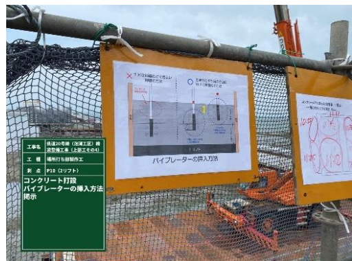
写真 13 パイプレータ挿入注意事項の掲示
