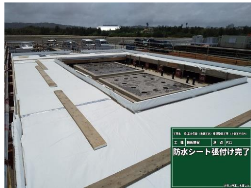
写真 12 柱頭部施工足場防水シートの設置
