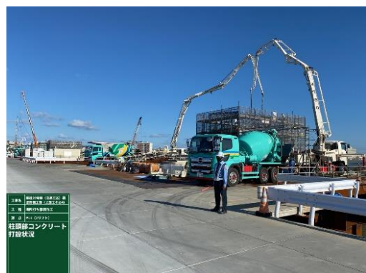
写真 15 コンクリート打設状況
