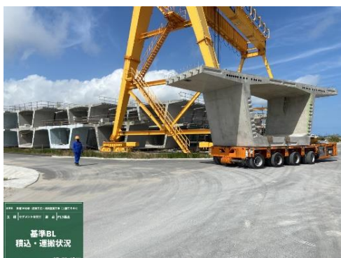
写真 6 セグメント桁運搬状況
