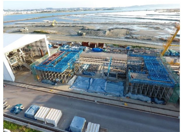
写真 3 鉄筋組立架台
