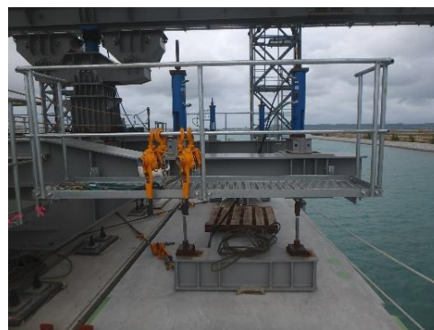
写真 7 基準セグメント専用吊り金具と固定状況
