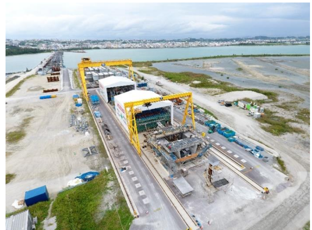
写真 1 セグメント製作設備全景
