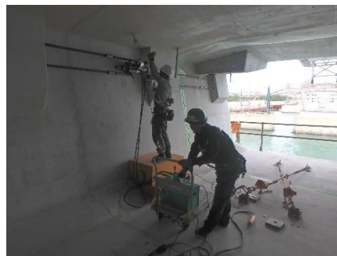
写真 8 引寄せ PC 鋼棒緊張状況
