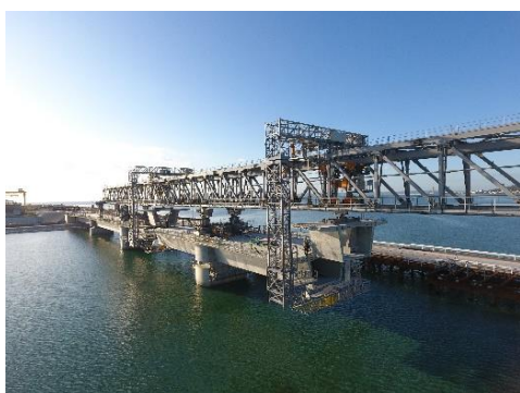
写真 5 架設設備全景
